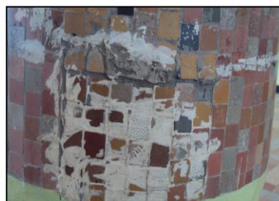
Photo6: Réparation agressive de la mosaïque. Source : Photo prise par auteur le 29 Avril 2013 à 10h.30.
