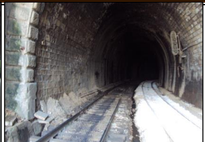
Photo3: Voie inondée causée par l’absence du drainage. Source : Photo prise par auteur le 29 Avril 2013 à 10h.30.
