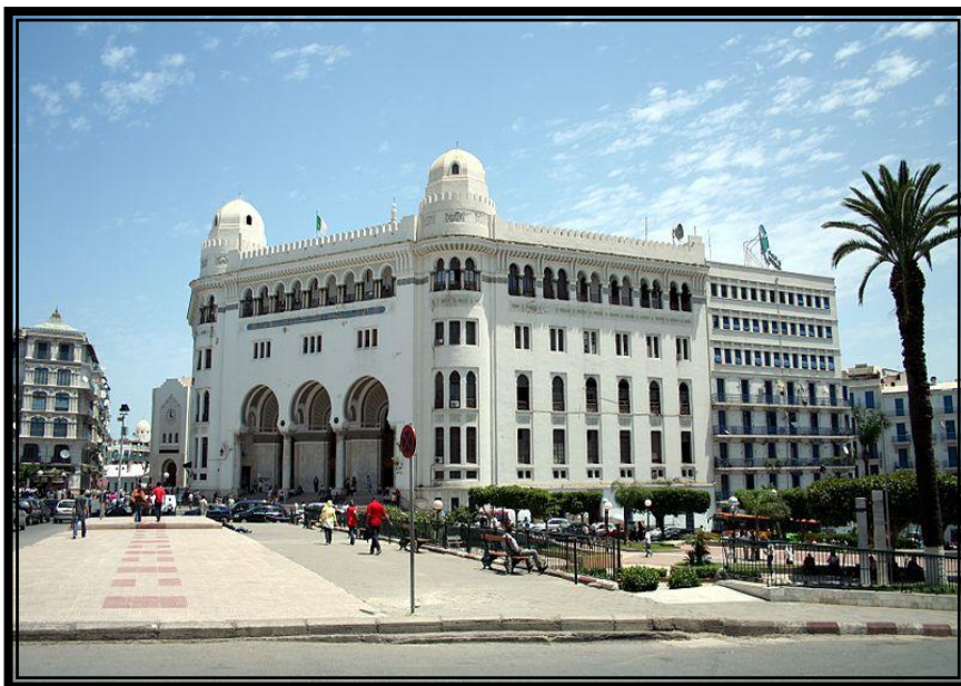
PHOTO :3 La grande poste d'Alger. Source : www.google.dz/images (2013)
