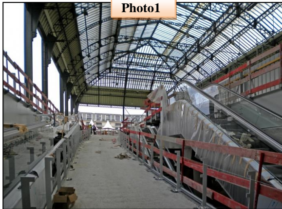
Photo1: travaux de création des nouveaux accès entre la plate forme jaune (nouvelle halle) et la salle méditerranéenne.
