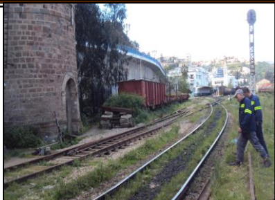
Photo1: Vieillesse et dégradation des voies. Source : Photo prise par auteur le 29 Avril 2013 à 10h.30.
