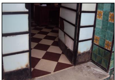
Photo8: Reprise aléatoire du carrelage par des motifs neufs. Source : Photo prise par auteur le 29 Avril 2013 à 10h.30.
