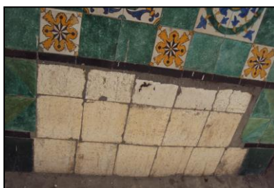
Photo7: Reprise aléatoire de la faïence par des motifs hétérogènes. Source : Photo prise par auteur le 29 Avril 2013 à 10h.30.
