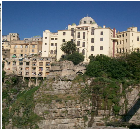
Photo2: Insertion de la Medersa de Constantine dans le front urbain de la vieille ville.
