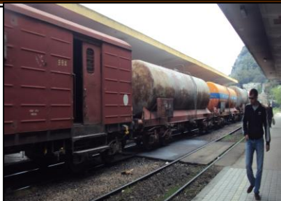
Photo2: Vétuste du matériel roulant. Source : Photo prise par auteur le 29 Avril 2013 à 10h.30.
