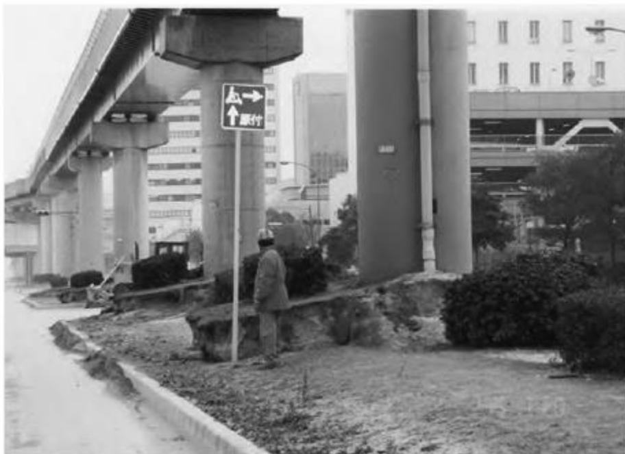
Figure 3.18- Tassement post-liquéfaction autour de la pile du viaduc dans le Port Island après le séisme de Kobe de 1995 (Idriss et Boulanger, 2008)
