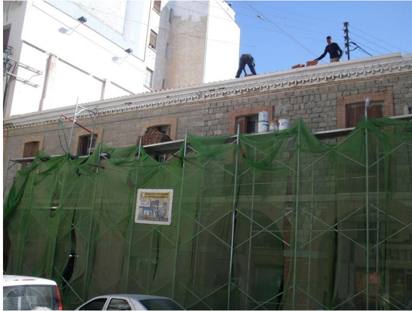
Photo 4. 6 : Façade principale pendant l'intervention.
