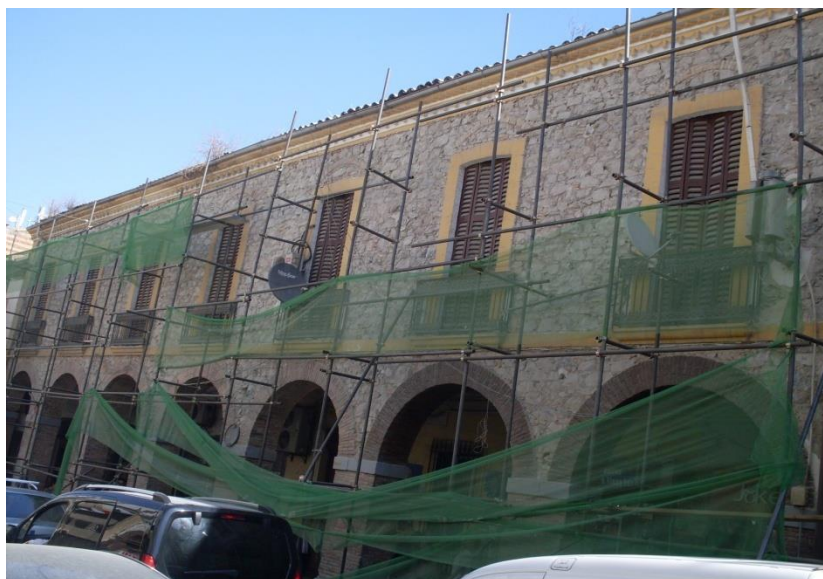
Photo 4. 5 : Façade principale avant intervention.
