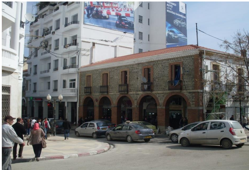
Photo 4. 7 : Façade principale après l'intervention.
