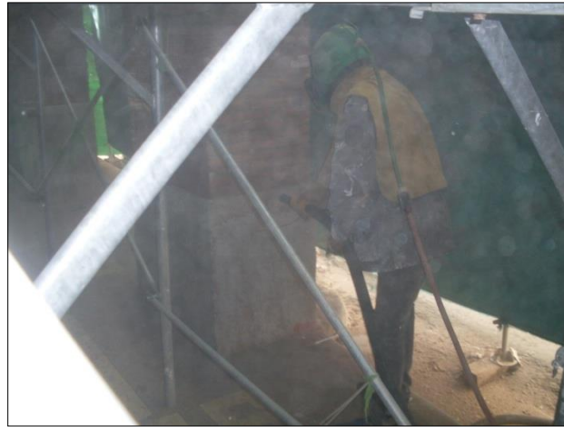
Photo 4. 4 : Sablage des surfaces
