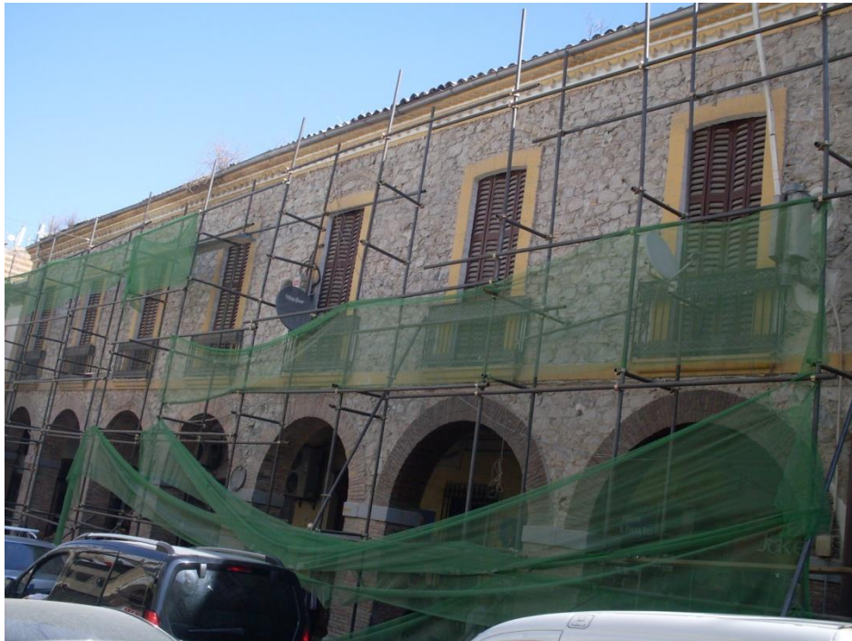
Photo 4. 3 : Dislocation du mortier de jointage
