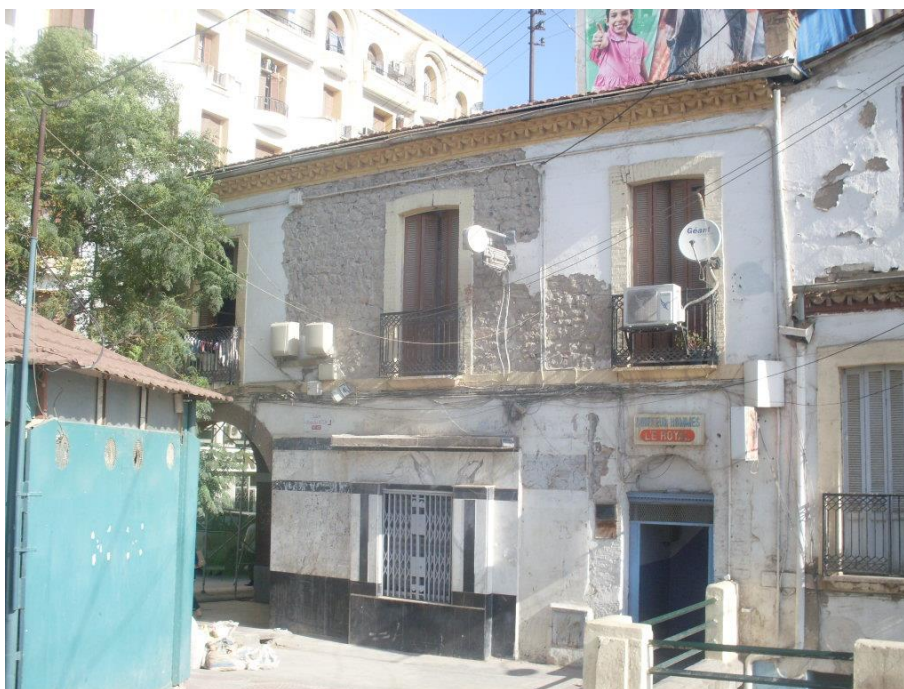
Photo 4. 1 : Façade principale de l'immeuble
