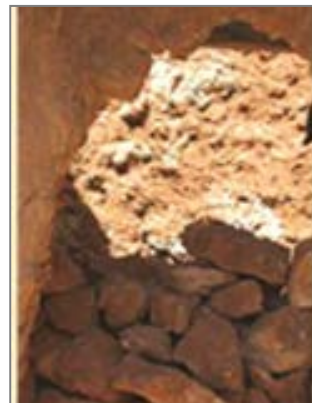
Figure II-5 : l'intérieur du four
