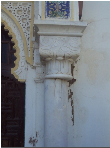
Photo I-15 : Déplacement de la colonne de marbre (mouvement du terrain) source : auteur (année 2013)
