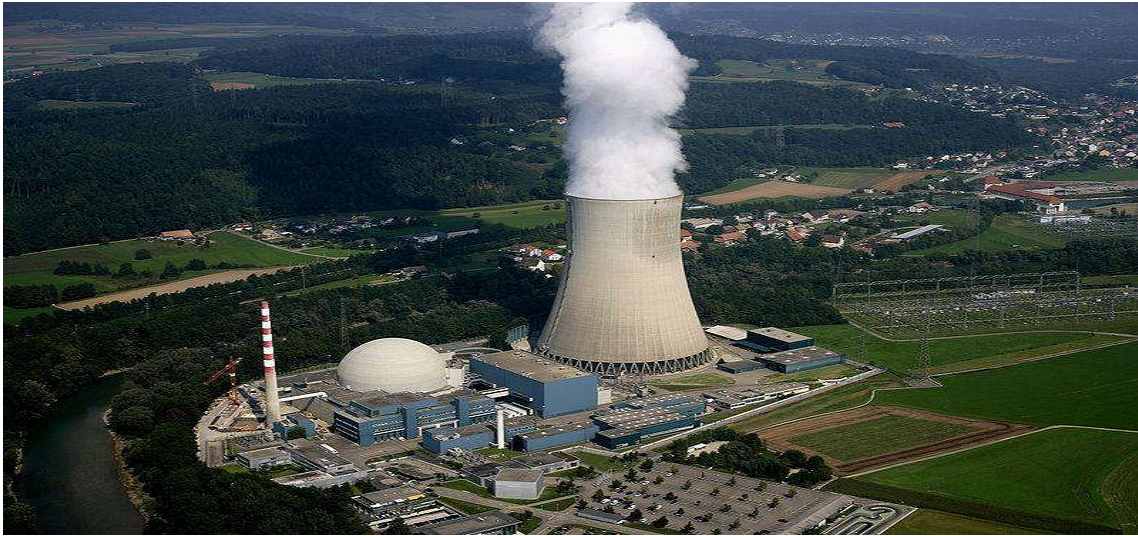
Fig. II.4 : Photo d'une tour de refroidissement dans une centrale thermique [70].
