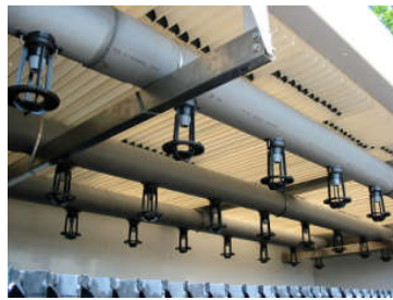
Fig.II.36 : Schéma d'un système de dispersion du fluide à refroidir [82].
