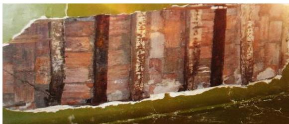
Figure n° 109: Plancher à voutain avec briques creuses et faux plafonds en bois porté avec des poutres métalliques en IPN.
