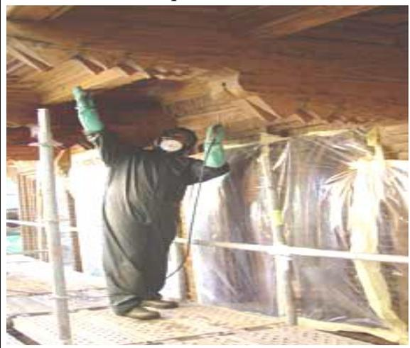
Figure n° 392: Injection profonde à l'aide de perforations alternées.
