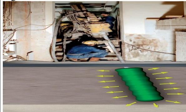
Figure n° 301 : Injection du mortier.
