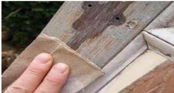
Figure n° 368 : Le renouvellement du mastic garantit l'étanchéité.
