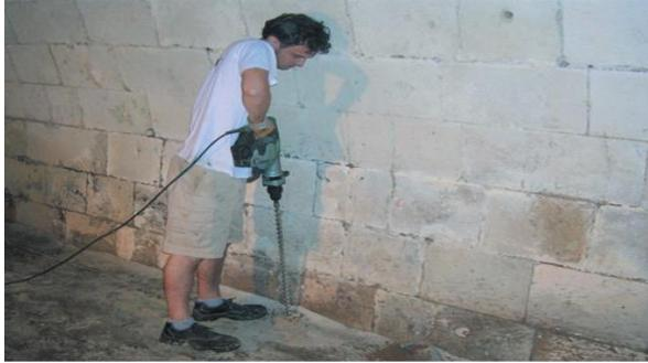
Figure n° 297: L'application des injections le long de la façade.
