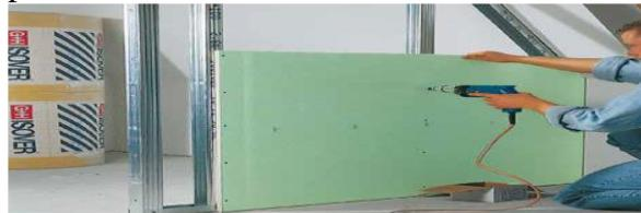
Etape 6: À présent, visser les plaques de plâtre Knauf en quinconce à l'aide de vis rapides de 25 mm sur la première face de la cloison. Une vis tous les 25 cm. Veiller à prévoir les emplacements nécessaires pour les prises de courant et les interrupteurs et à faire passer préalablement les fils à travers les ouvertures prévues dans les profilés Knauf CW.
