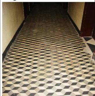
Figure n° 112 : reprise du carrelage détaché par un plus récent.
