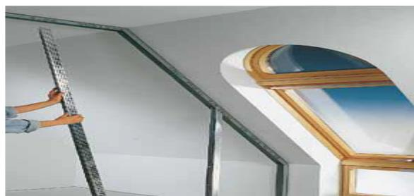
Etape 4: Il s'agit maintenant d'insérer progressivement les autres profilés Knauf CW dans les profilés Knauf UW à une distance de 30-40 cm (selon la largeur du panneau et le type de revêtement).
