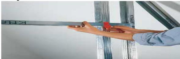
Etape 5: Si vous voulez prévoir une porte dans la cloison, il vous suffit de faire glisser le profilé de linteau Knauf, découpé en fonction de la largeur de la porte, à la hauteur correspondante sur le profilé Knauf CW et de le fixer avec du ruban adhésif. Pour stabiliser le tout, placer et fixer un bois équerri dans le montant vertical de la porte.
