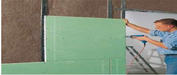
Etape 7 : Après avoir monté les panneaux isolants Knauf Insulation TP 416 entre les montants CW, il faut également recouvrir la deuxième face de plaques de plâtre Knauf.
