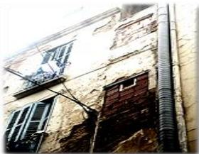
Figure n°171 : La dégradation des enduits sur façade.
