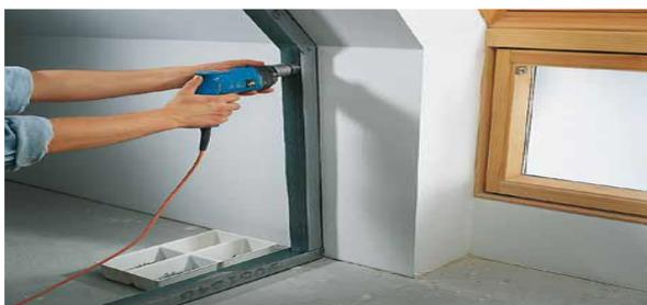
Etape 3 : Emboîter à présent le premier profilé Knauf CW (profilé vertical) dans le profilé Knauf UW et le fixer avec au moins 3 chevilles sur les murs latéraux. Ici aussi, la bande d'étanchéité est à coller préalablement.
