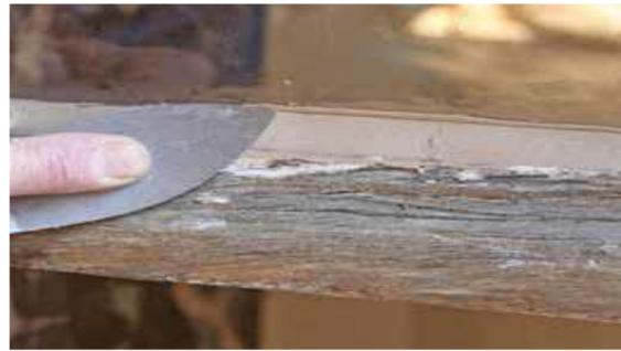
Figure n° 369: Remplacement des éléments trop dégradés, souvent en partie basse.
