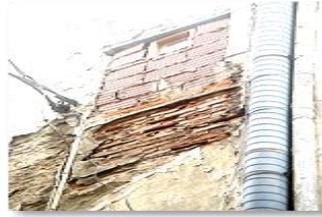
Figure n°173 : La dégradation des enduits, façade sur patio.
