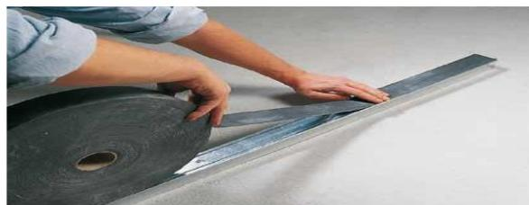
Etape 2 : Afin d'obtenir une isolation acoustique optimale, coller la bande d'étanchéité autocollante au profilé Knauf UW découpé sur mesure (pour sols et plafonds). Fixer ensuite le profilé à l'aide de chevilles au plafond et au sol (distance cheville maximum 1 m).
