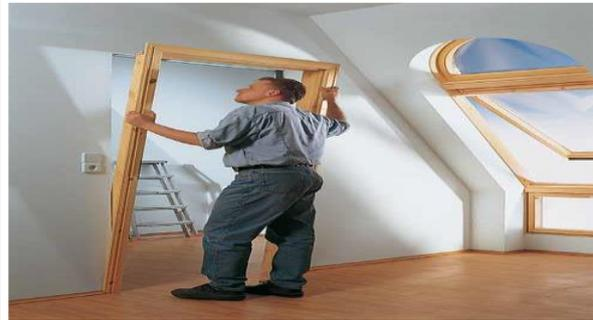
Etape 10 : Insérer ensuite l'ébrasement de la porte dans l'ouverture. Afin de lui garantir une fixation durable et stable dans la percée, le fixer avec la mousse PU Knauf.
